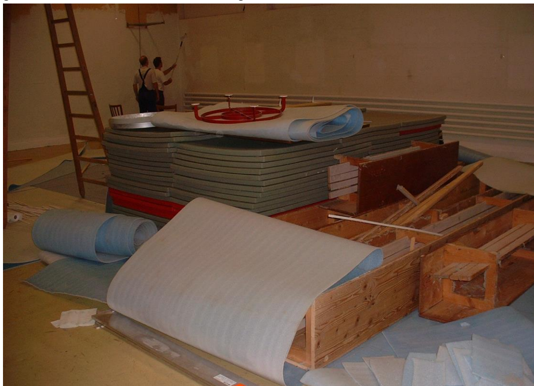
ABBILDUNG 30: RENOVATION DES DOJOS 2003 (QUELLE: RENÉ WIDTMANN)
